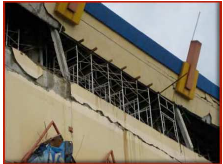
Cedarea stâlpilor de la ultimul nivel
