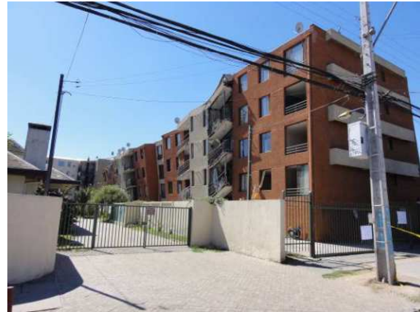
Sisteme structurale diferite la parter – lipsa rostului seismic
